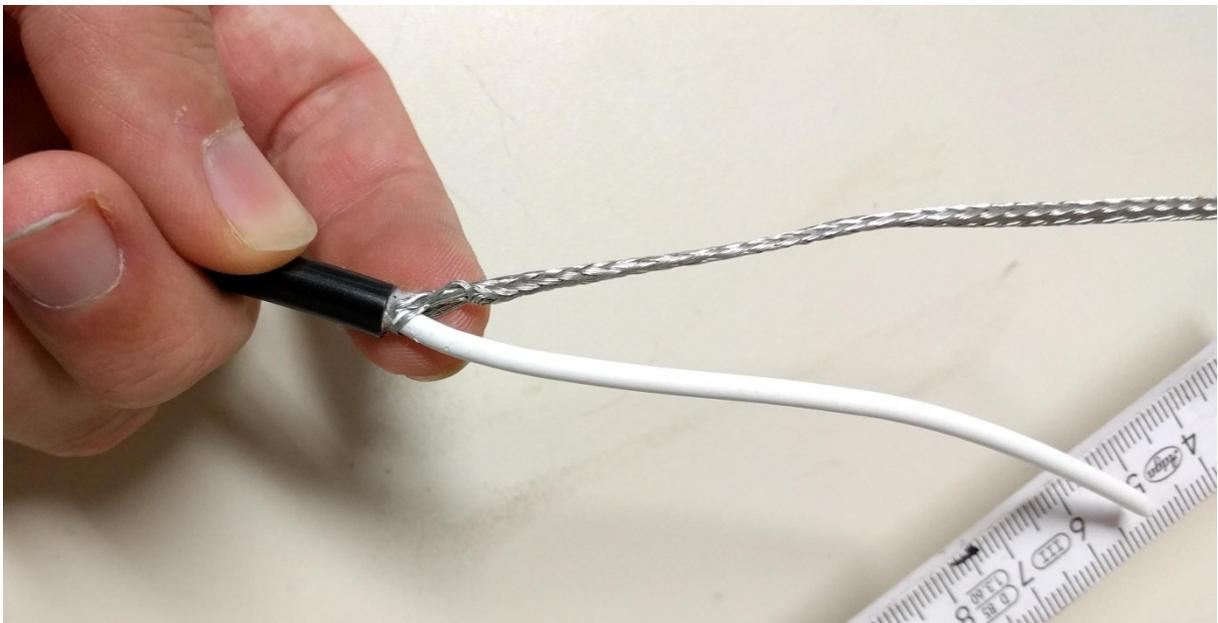
9. Vor dem Isolieren mit Schrumpfschlauch empfiehlt es sich, die Leiter mit Aderendhülsen zu verpressen. So könnt ihr anschließend den Schrumpfschlauch leicht über die Aderendhülse überlappen lassen.
